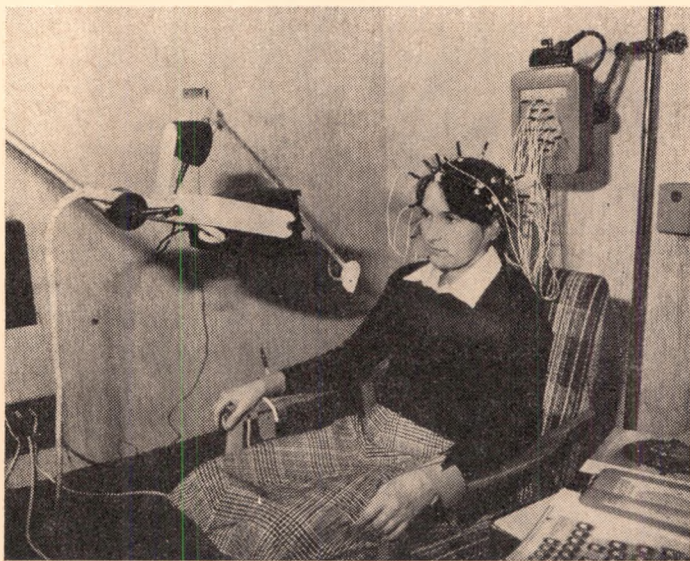
Obr. 6 Ústav fyziologických regulací ČSAV, Praha Pokusná osoba uvnitř pavlovovské komory (opatřena elektrodami pro EEG, EKG, zdroje podnětů optických a akustických, snímací TV kamera)
