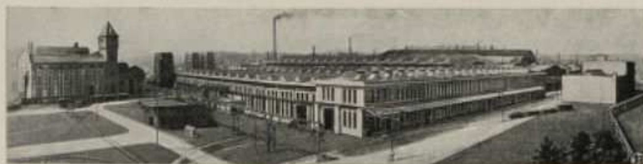
Tovární budovy První brněnské strojirenské spol. v Brně.
